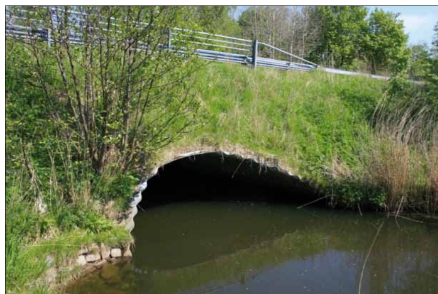
Figur 3. Ved at lave en kort dæmning med et regulerbart lukke foran denne vej kan man i mange situationer tilbageholde tilstrækkelig vand til at undgå oversvømmelser i Præstø by
